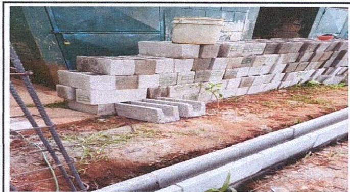
Foto 3: Construcción de muro perimetral de baños y cocina
