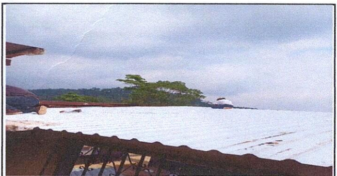
Foto 6: Cambio de techado primer módulo
