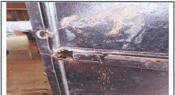
Foto 4: Cambio de chapas de las puertas del primer módulo
